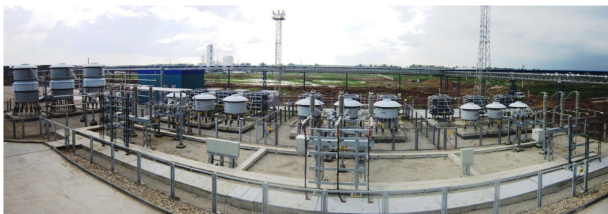
Рис. 6. ООО «НЛМК-Калуга», СТК 35 кВ 180 Мвар для ДСП 150 МВА и АПК 16 МВА
